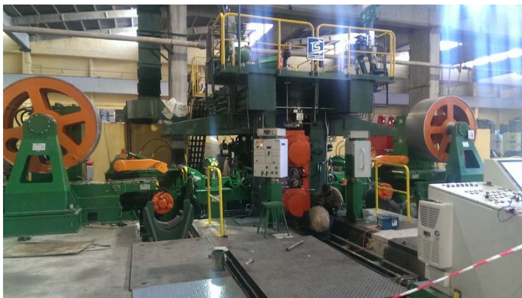
Obr. 8 Projekt modernizace studené KVARTO trati v Pákistánu, kde byla aplikace pro řízení a optimalizaci studených válcoven úspěšně testována
